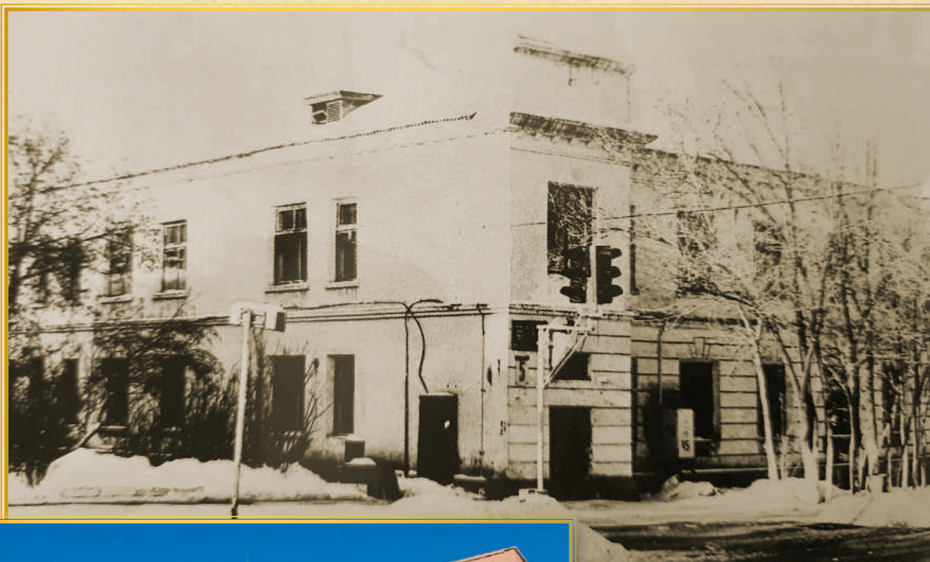
Бывшее здание прокуратуры области по ул. Джамбула, 5
